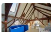
10 DŮM NA ŽLUTÉM KOPCI BRNO Realizační firma: Tomáš Miksa
