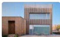
1 RODINNÉ A FIREMNÍ SÍDLO EKO MODULAR TVRDONICE Realizační firma: Eko modular s.r.o.
