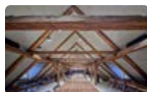
13 REZIDENCE LATRÁN ČESKÝ KRUMLOV Realizační firma: SÁDROKARTONY ŠINKA s.r.o.
