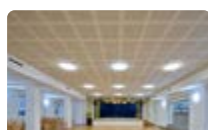
18 KULTURNÍ DŮM HÁJEK OSTROV Realizační firma: Suché stavby Cheb, s.r.o.
