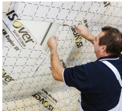
Aplikace parozábrany (v oblasti střešního okna parozábrana proříznuta ve tvaru písmene „I“)
