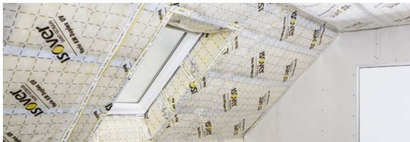
Podkroví po aplikaci parozábrany
