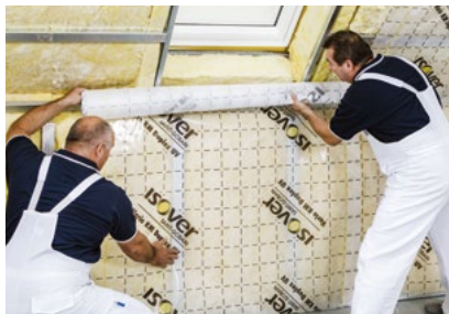
Instalace parozábrany – parozábrana na podkonstrukci
