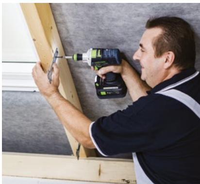
Přípevnění závěsů do dřevěných krokví
