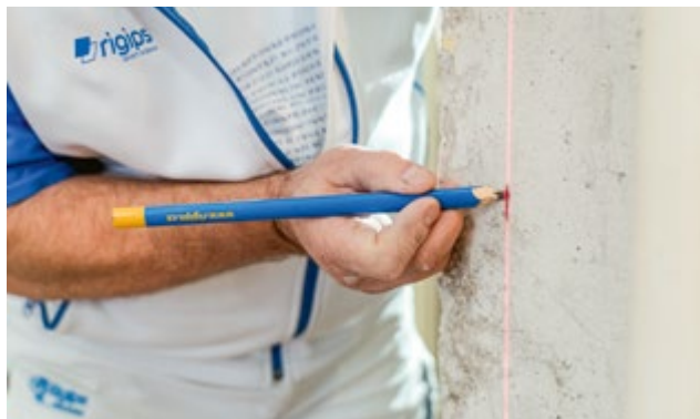
Vyměření příčky např. pomocí laseru
