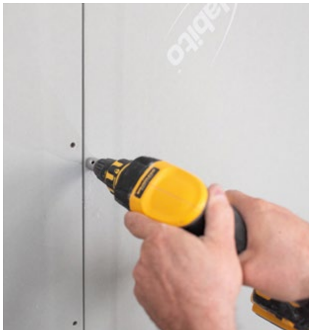
Montáž opláštění
