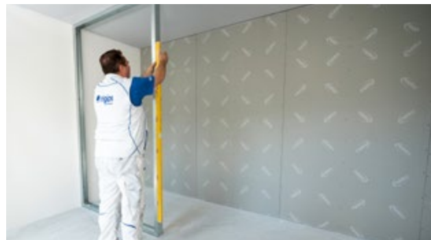
Montáž nosné konstrukce příčky – svislé profily R-CW
