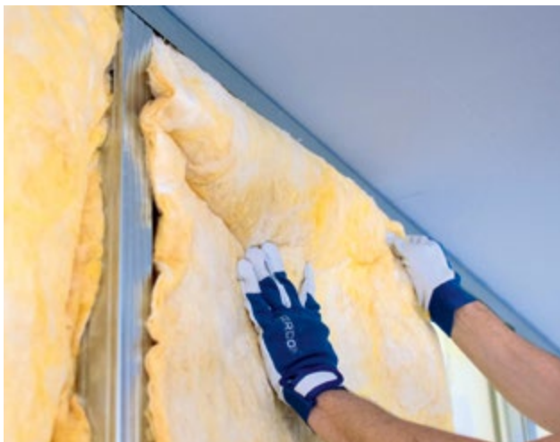
Vložení minerální izolace do dutiny příčky
