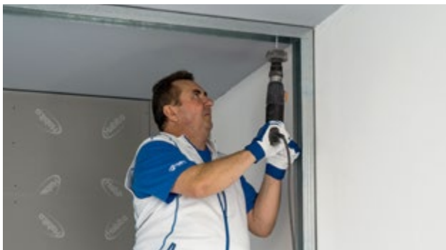
Montáž nosné konstrukce příčky – obvodové profily R-UW
