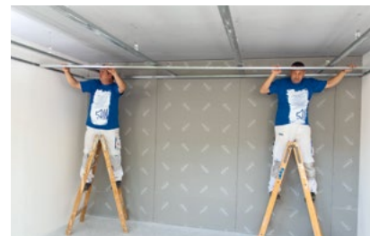
Montáž nosných a montážních profilů křížového dvouúrovňového roštu
