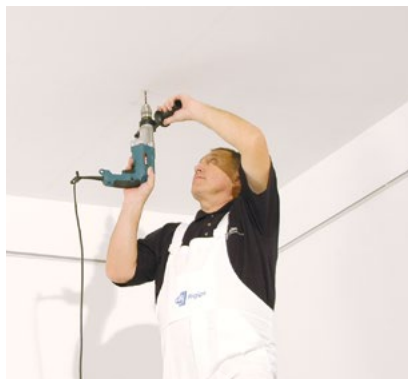
Kotvení závěsů do nosného stropu
