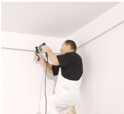
Montáž obvodových profilů
