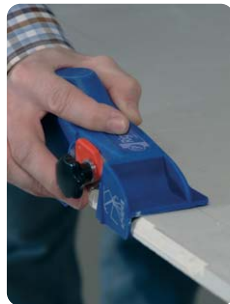
Příčná spára se zkosenou hranou
