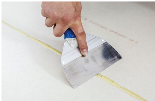
Seškrábnutí vypěněného polyuretanového lepidla
