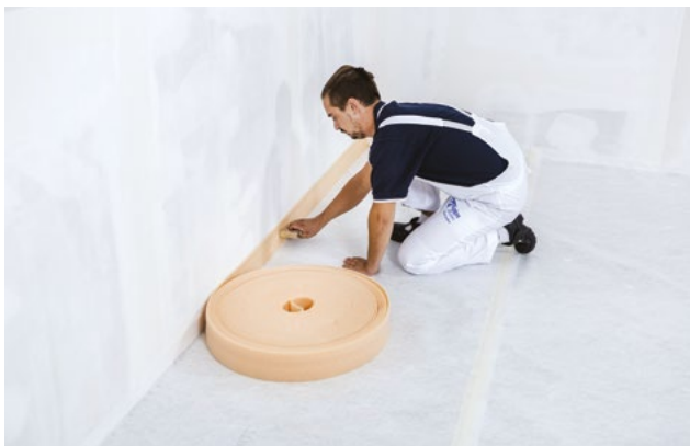
Aplikace obvodového pásku
