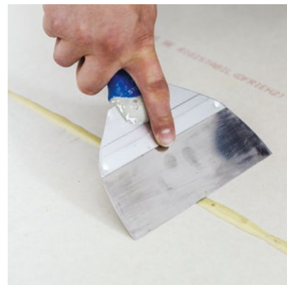
Stržení vypěněného polyuretanového lepidla
