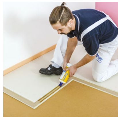
Nanesení podlahového polyuretanového lepidla
