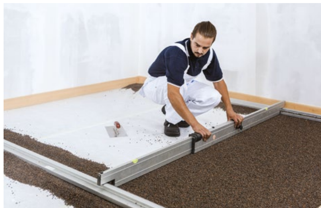
Výškové vyrovnání podsypu
