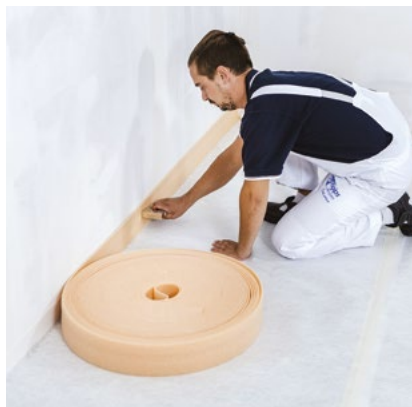
Přípevnění okrajových pásků
