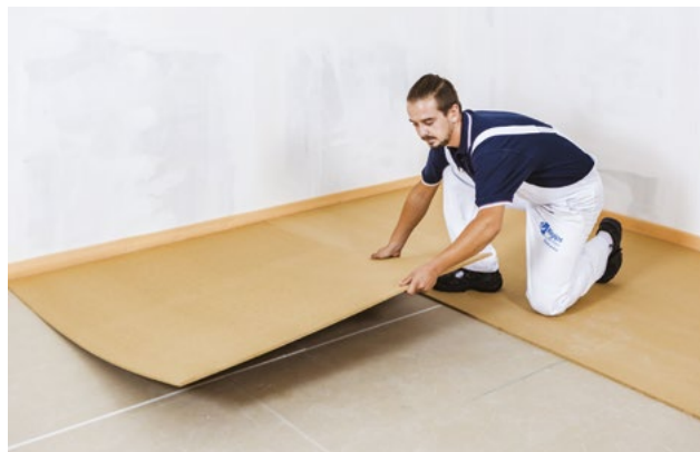
Pokládka izolantu (dřevovláknitých desek)
