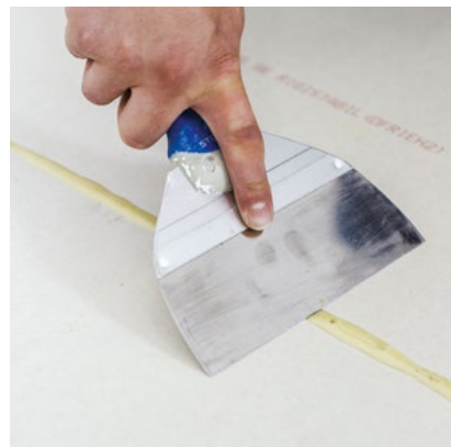
Stržení vypěněného polyuretanového lepidla
