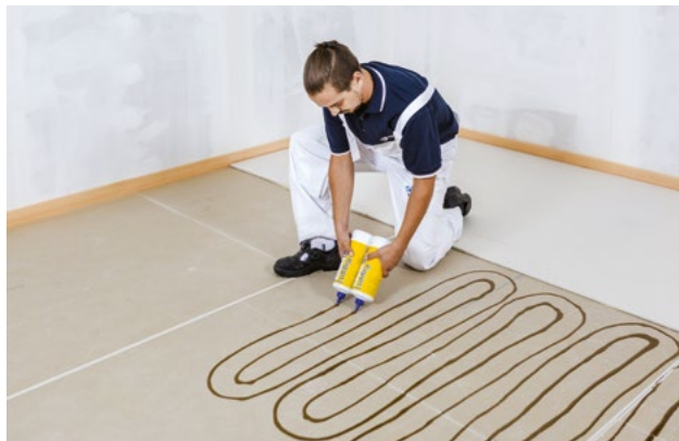
Prolepení desek podlahovým lepidlem Rigidur
