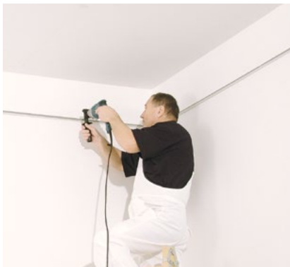
Montáž obvodových profilů
