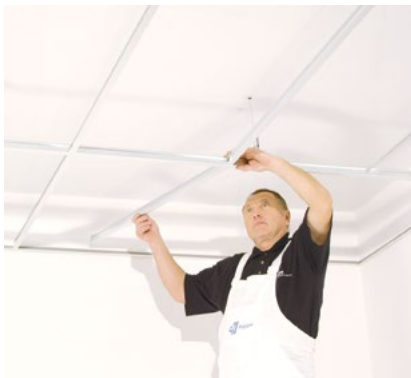
Osazení příčných profilů délky 1 200 mm
