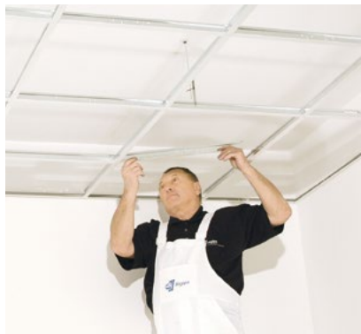
Osazení příčných profilů délky 600 mm
