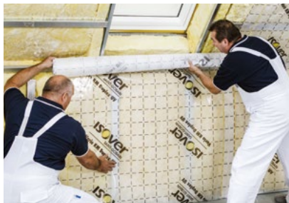
Instalace parozábrany – parozábrana na podkonstrukci
