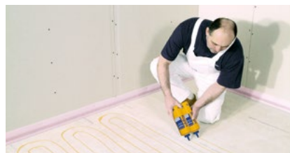
Nanášení lepidla v pruzích
