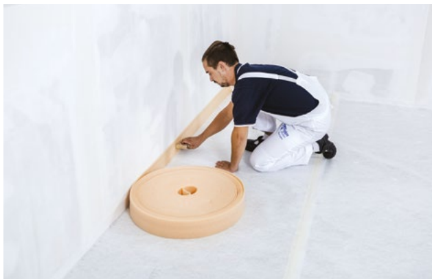
Aplikace obvodového pásku
