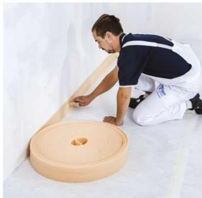
Přípevnění okrajových pásků
