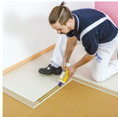
Nanesení podlahového polyuretanového lepidla
