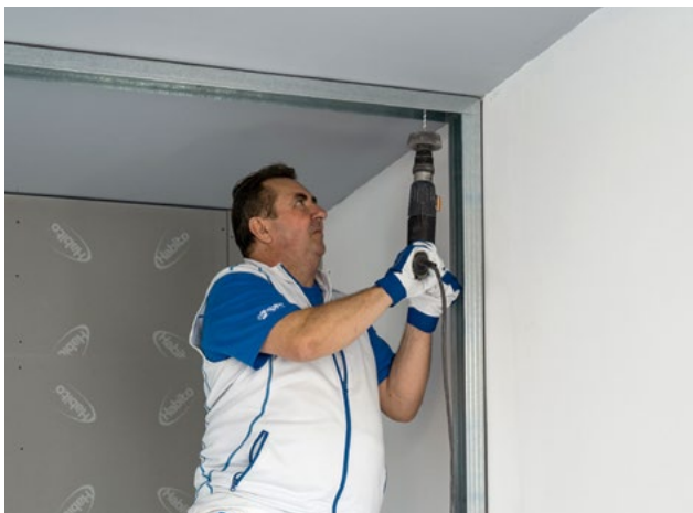
Montáž nosné konstrukce příčky – obvodové profily R-UW
