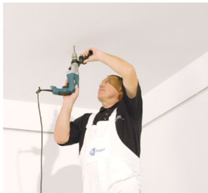
Kotvení závěsů do nosného stropu
