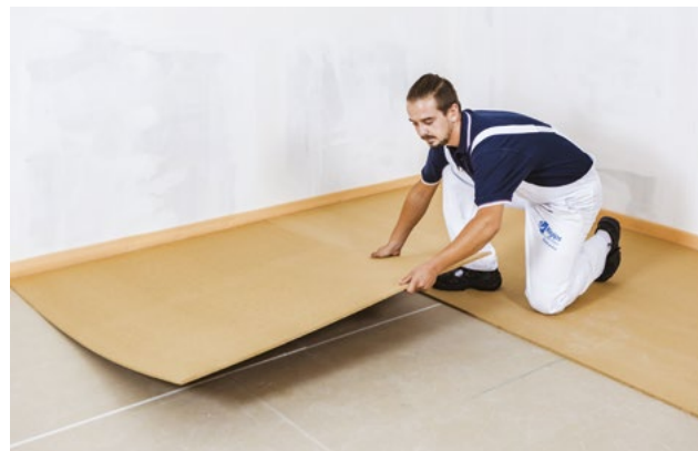
Pokládka izolantu (dřevovláknitých desek)
