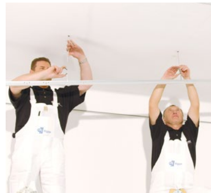
Osazení hlavních T-profilů
