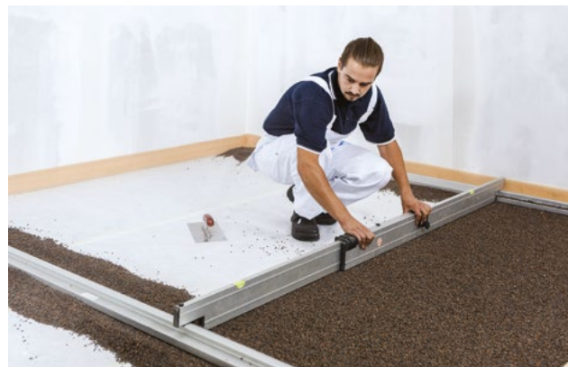
Výškové vyrovnání podsypu
