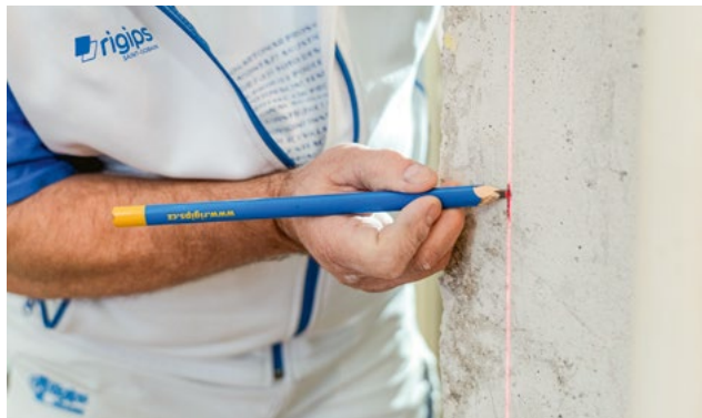
Vyměření příčky např. pomocí laseru
