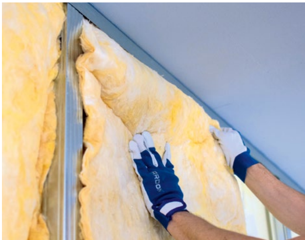
Vložení minerální izolace do dutiny příčky
