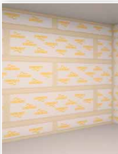
8. Tmelení vodorovných spár druhé vrstvy
