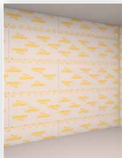
6. Montáž druhé vrstvy desek
