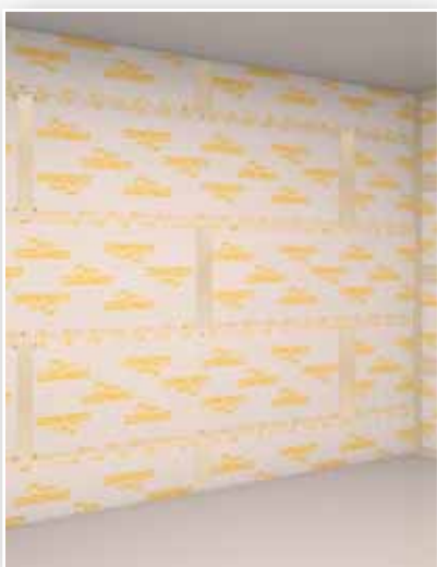
7. Tmelení svislých spár druhé vrstvy
