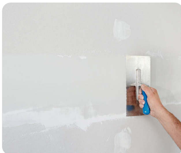
Po zaschnutí první vrstvy tmelu se spáry přestěrkují, hranou hladítka se tmel roztáhne do šířky a uhladí do ztracena. Konečnou úpravu povrchu - finální tmelení - je možno provést např. pastovým (finašovací) tmelem ProMix Finish (popř. ProMix Mega).
