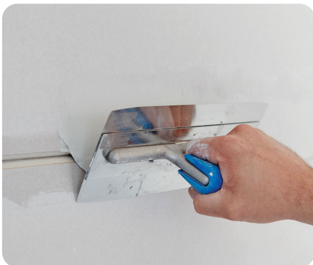
Příčnou spáru vyplníme sádrovým tmelem...
