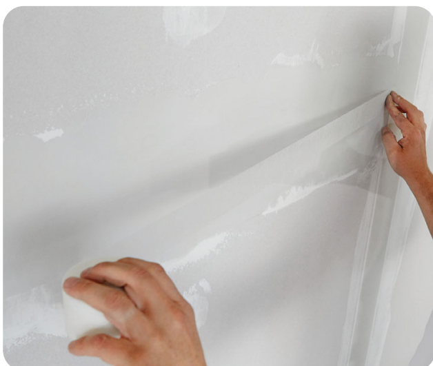
Po zaschnutí a mírném propadnutí tmelu spáru doplníme a aplikujeme skelnou výztužnou pásku do tenké vrstvy čerstvého tmelu.
