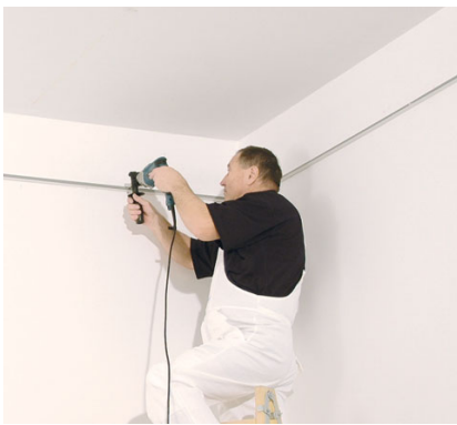
Montáž obvodových profilů
