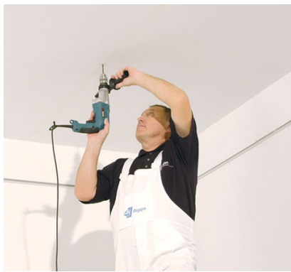
Kotvení závěsů do nosného stropu
