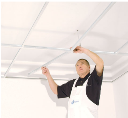
Osazení příčných profilů délky 1 200 mm
