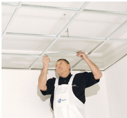
Osazení příčných profilů délky 600 mm
