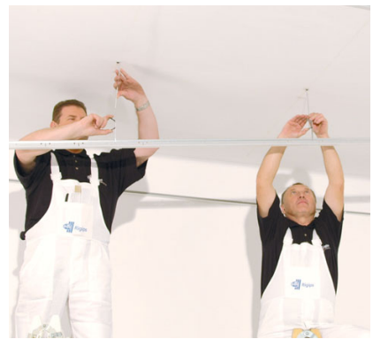
Osazení hlavních T-profilů
